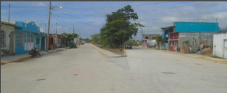
**CONSTRUCCIÓN DE PAVIMENTO DE CONCRETO HIDRÁULICO, GUARNICIONES Y BANQUETAS EN LA CALLE LAGUNA EL TIGRE**
